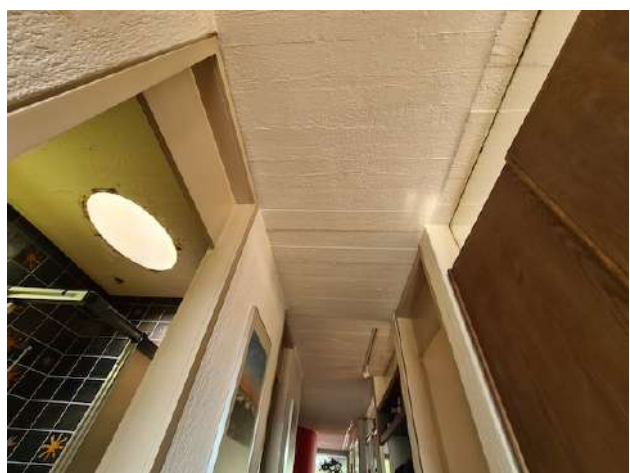
L'interface du tube en fibre-ciment amiante se délite avec la condensation et le temps. La disparition de l'étanchéité en toiture accélère le processus de dégradation. La peinture sur béton du plafond ne contient pas d'amiante (échantillon S03-PEIN_FP).
