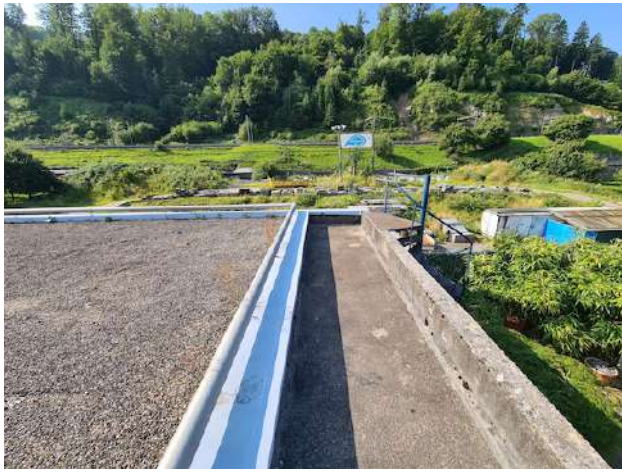
Aperçu de la toiture avec une moitié sud en toiture métal (couvert en pente) et une moitié nord d'origine toiture plate ancienne de 1973.
