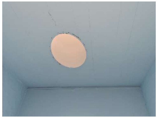
Puit de lumière avec un conduit en fibrociment qui traverse la dalle supérieure
