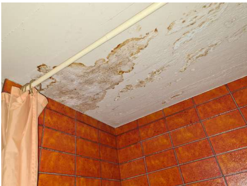
De nombreux vices liés à l'humidité sont visibles à l'étage
