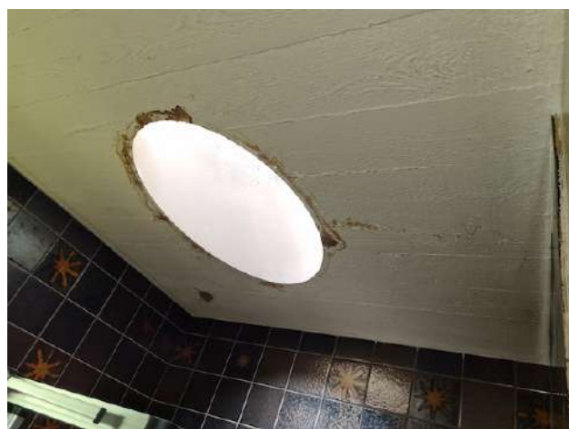
L'interface du tube en fibre-ciment amiante se délite avec la condensation et le temps. La disparition de l'étanchéité en toiture accélère le processus de dégradation. La peinture sur béton du plafond ne contient pas d'amiante (échantillon S03-PEIN_FP).
